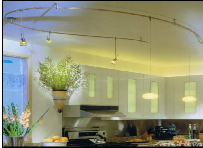
Hình 1.2. Hệ thống điện phòng bếp
