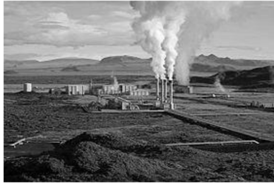
Hình 1.9 Nhà máy điện địa nhiệt Nesjavellir ở Iceland
