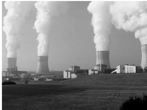
Hình 1.12 Nhà máy điện nguyên tử ở Cattenom, Pháp
